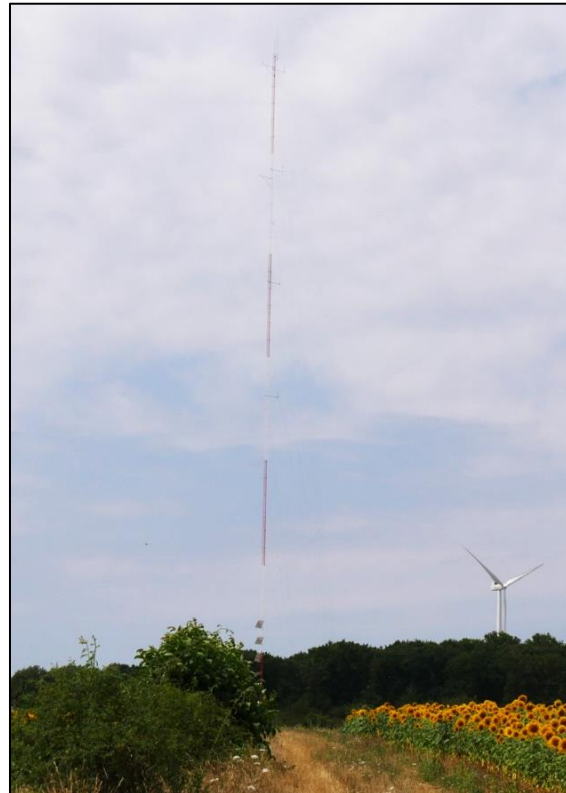
Figure 31 : Mât de mesures anémométriques du projet des Mignaudières 2 (Crédit photo : NCA Environnement, 21 juillet 2020)
