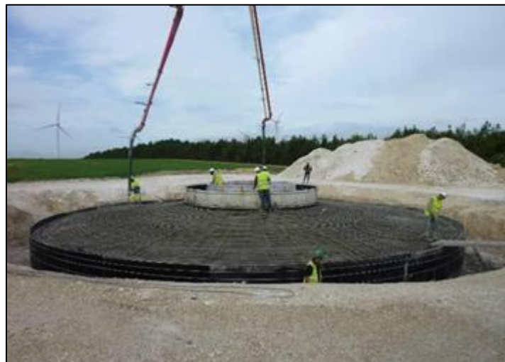
Figure 38 : Photographie de la mise en œuvre d'une fondation (Source : ABO Wind)
