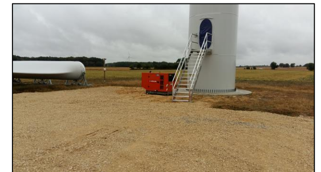
Figure 37 : Plateforme et zone de stockage (Source : ABO Wind)
