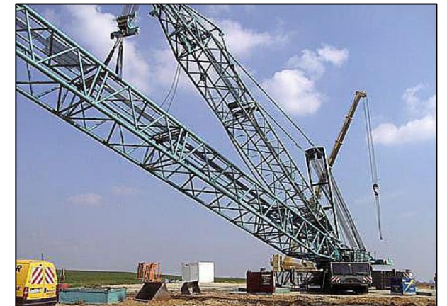
Figure 36 : Grue de levage sur une plateforme (Source : ABO Wind)
